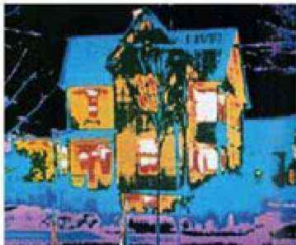
图 7.10-1 一座房屋的红外照片（红外照片是不能分辨颜色的，图中的颜色是为区分不同的温度而在照片处理时加上的），可以看出，由于取暖和使用电器，室内温度比室外高。热量散失到室外后，不能回收重新利用。
