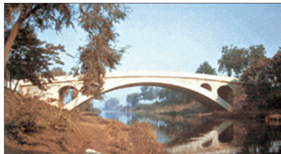
建于公元591~599年的赵州桥：世界上第一座敞肩式石拱桥。全长50.82m，跨度37.37m，桥面宽9m
