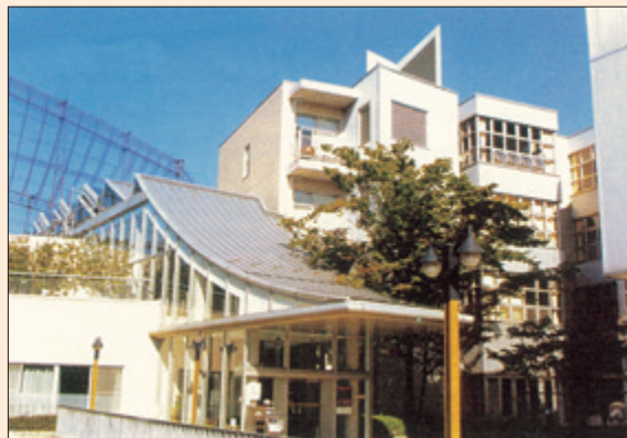
日本东京芦花之家老年公寓入口顶部的太阳能集热板
