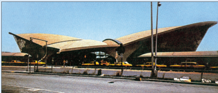
美国纽约环球航空公司候机楼
