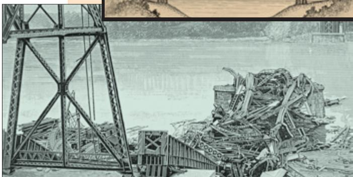
大桥坍塌的原因是设计师在没有对桥梁的关键部位做相应加固的情况下,擅自将原来的500 m的桥长延长到了600 m,造成了大桥南端制动臂上的压力索发生弯曲,从而导致整个上层结构倾塌。
