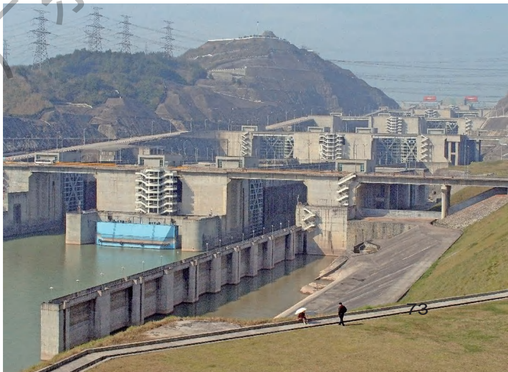
图8-21 五级方式的三峡船闸
