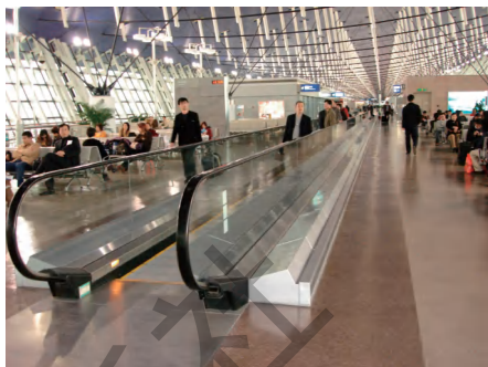
图7-4 机场候机楼中的自动人行道
