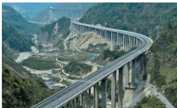
图7.50 翻山越岭的雅安—西昌高速公路
