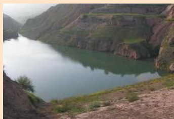
图6.7 建成蓄水的淤地坝
