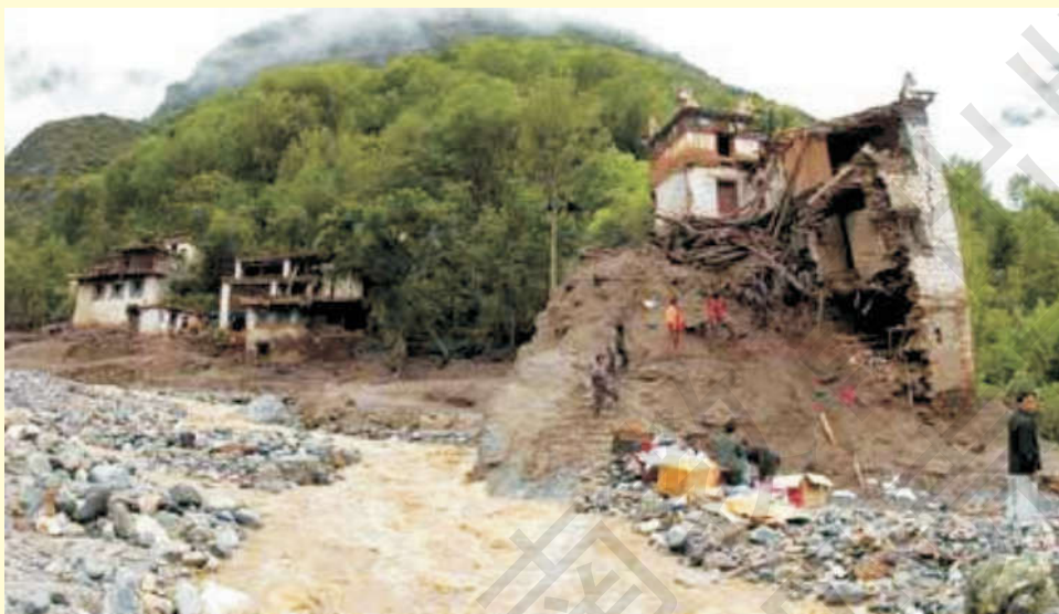
图 4-8 泥石流冲毁的民房
