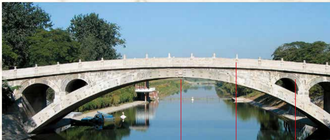
安济桥（又称赵州桥，建筑）隋代
