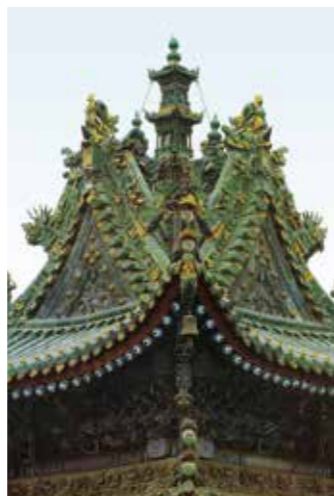
陕西某钟楼屋顶 明清
