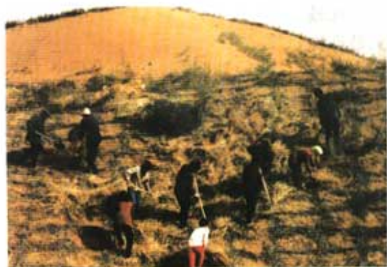
图 5-8 草方格阻止沙丘移动
