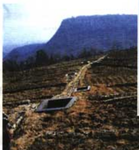
图 5-12 干旱地区的集雨井
