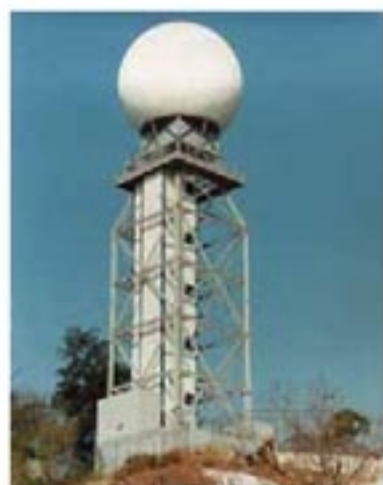
图 14.4-6 一些雷达天线外面装有球形防护罩。防护罩由能够透过无线电波的材料制成。
