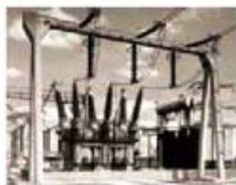
甲 变电站的大型变压器
