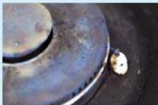
图1.3-13 电子点火器的针状电极
