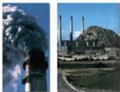
图1.3-10 燃煤时会产生大量煤灰，污染大气。在烟囱底部安装静电除尘器就可以把煤灰除掉。
