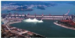
三峡大坝溢流
