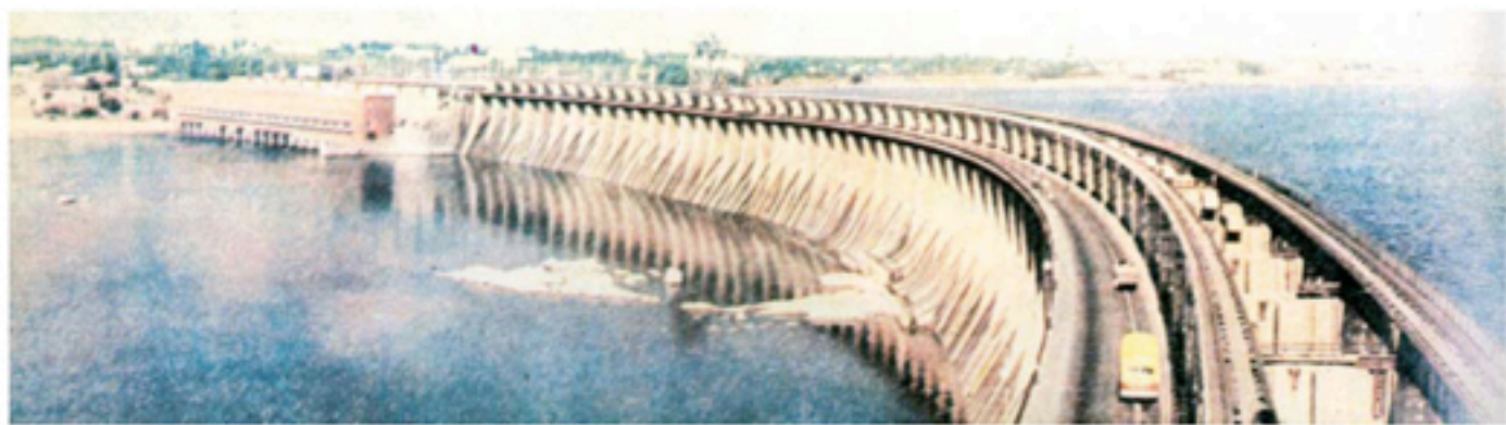
苏联工业化中的重要工程之一——第聂伯河水电站
