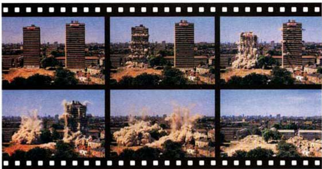
图 2-20 建筑物的定向爆破
