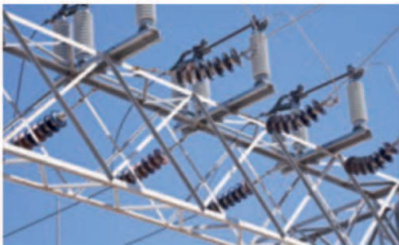
图5-20 高压输电线路使用了陶瓷绝缘材料
