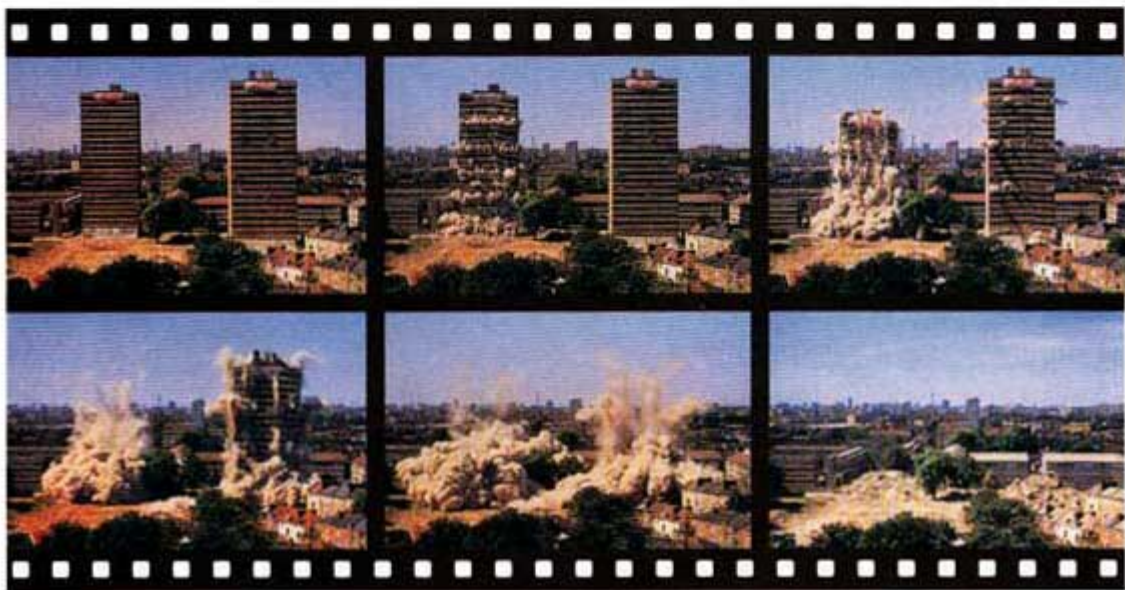
图 2-20 建筑物的定向爆破
