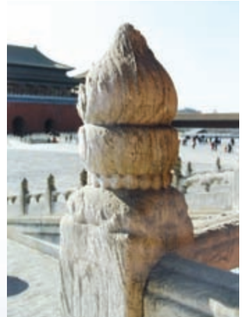
图22.4-3 被酸雨严重腐蚀的汉白玉石柱
