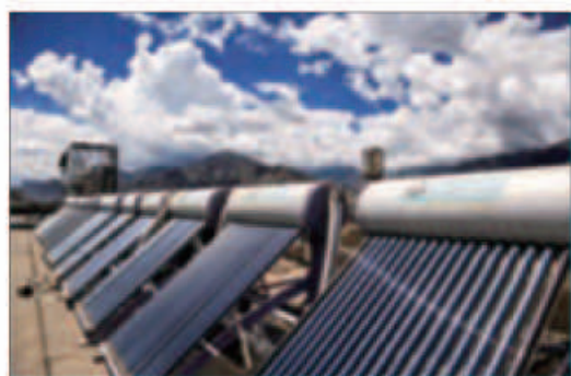
图6-94 安装太阳能热水器的屋顶
